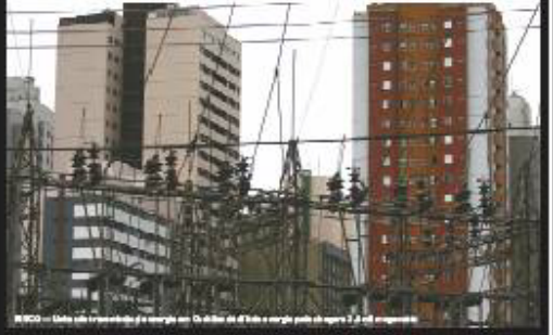
RECIFE - Uma sala de controle de energia em Recife. De cima à direita, a energia passa de uma torre 7,2 mil metros.
