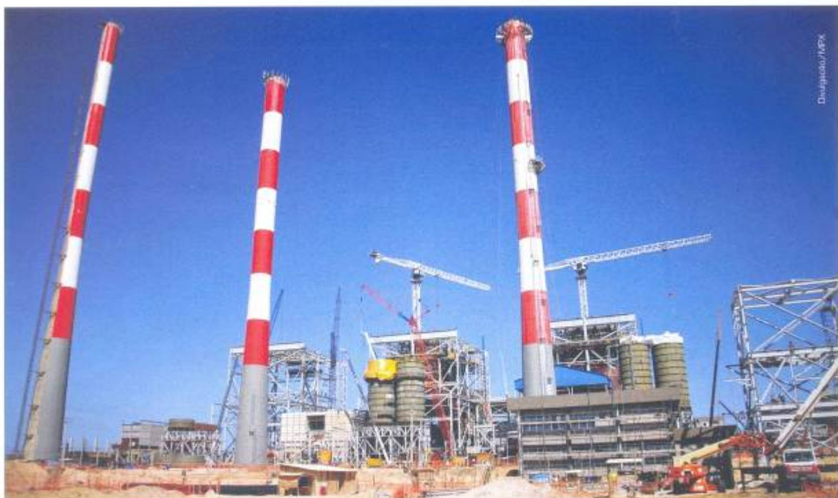
Obras em andamento em termelétrica da MPX; empresa, que também tem gás próprio, competiu de perto com eólicas
