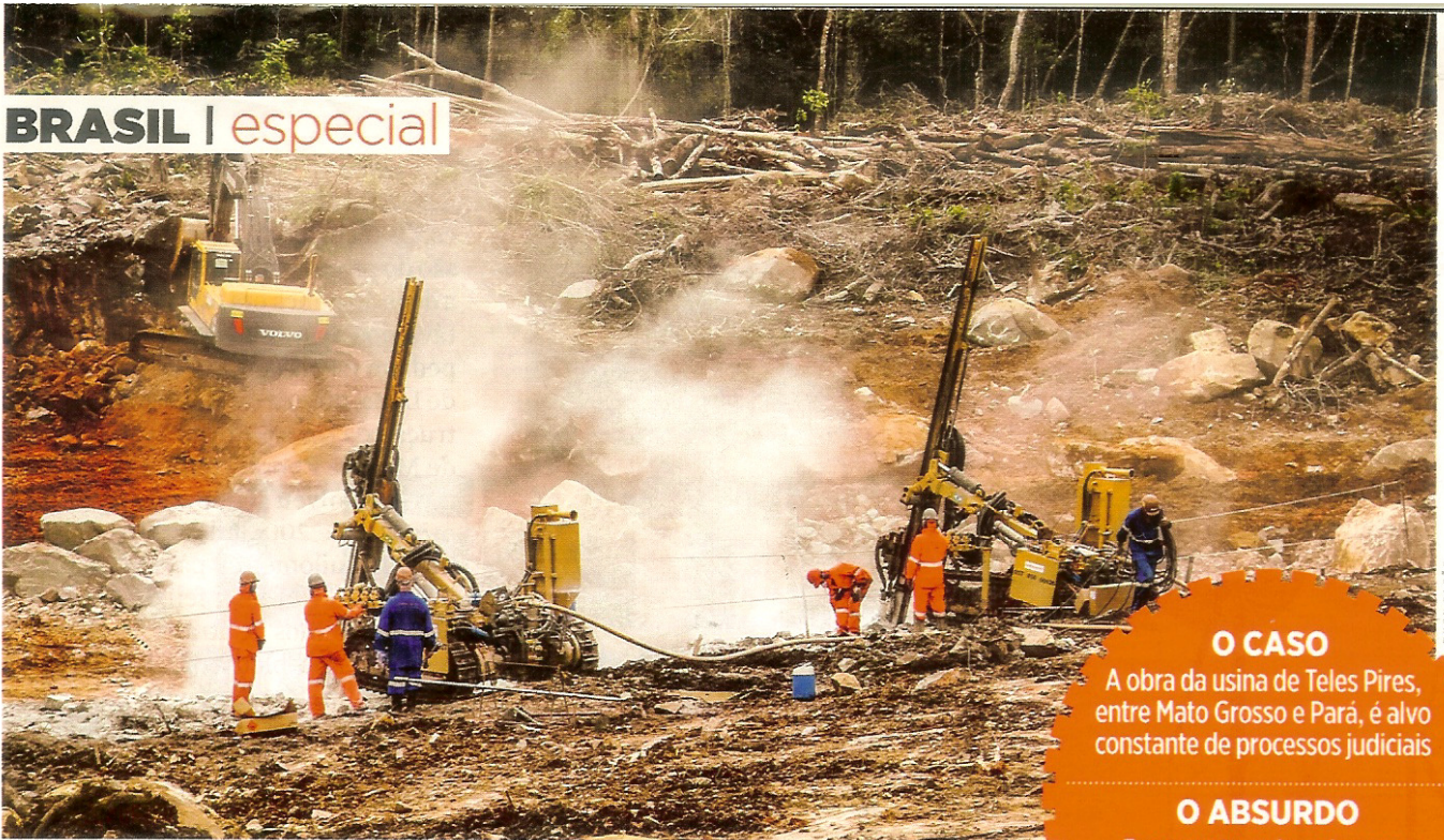
CONSTRUÇÃO DA USINA DE TELES PIRES: 27 ações na Justiça em pouco mais de um ano
