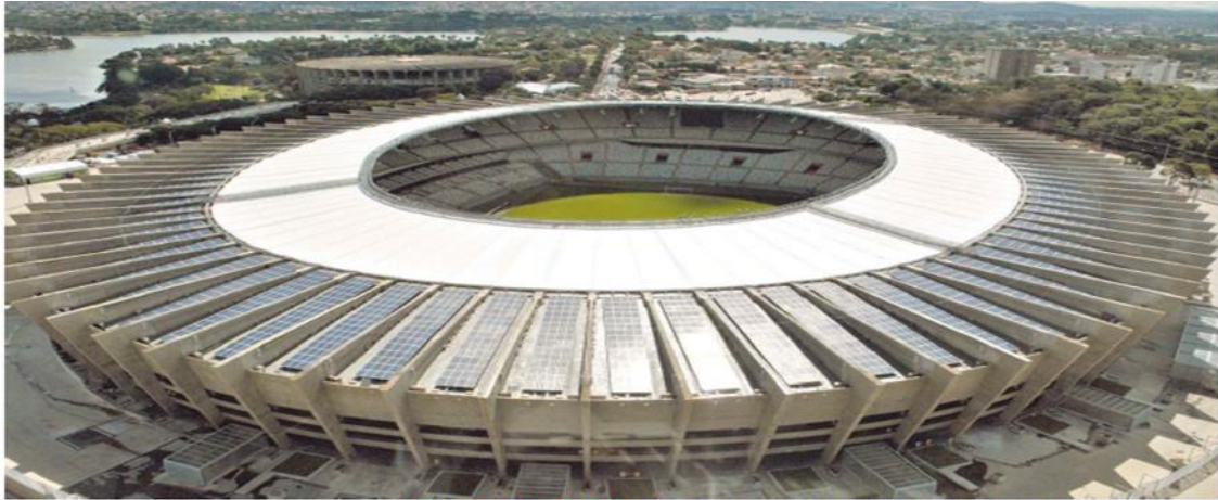
FONTE ALTERNATIVA – Usina solar do Mineirão: cobertura do Estádio recebeu painéis para geração de energia fotovoltaica
