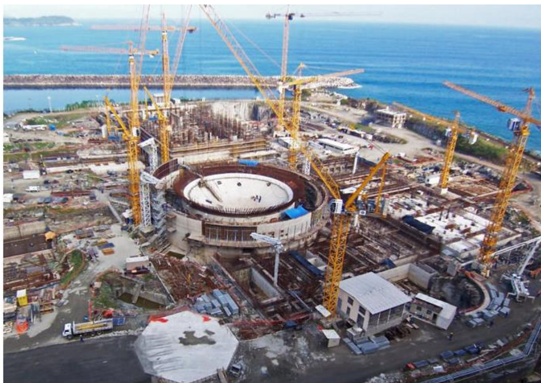
Vista geral das obras na usina de Angra 3 no Rio de Janeiro(Flickr/PAC 2/Divulgação)
