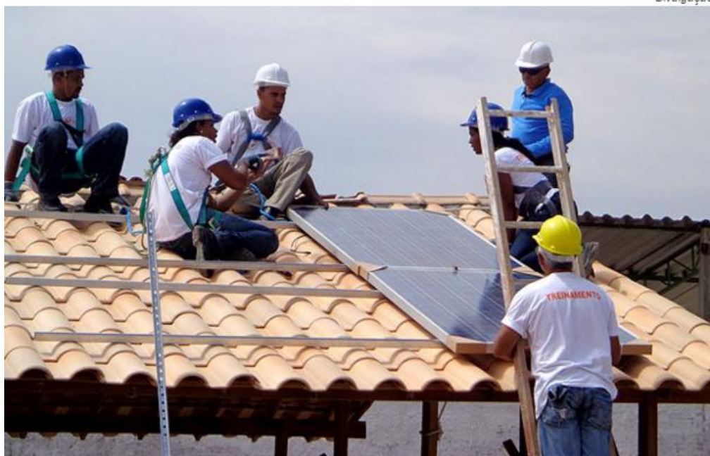
Painel fotovoltaico é instalado em residência do Minha Casa, Minha Vida em Juazeiro (BA)
