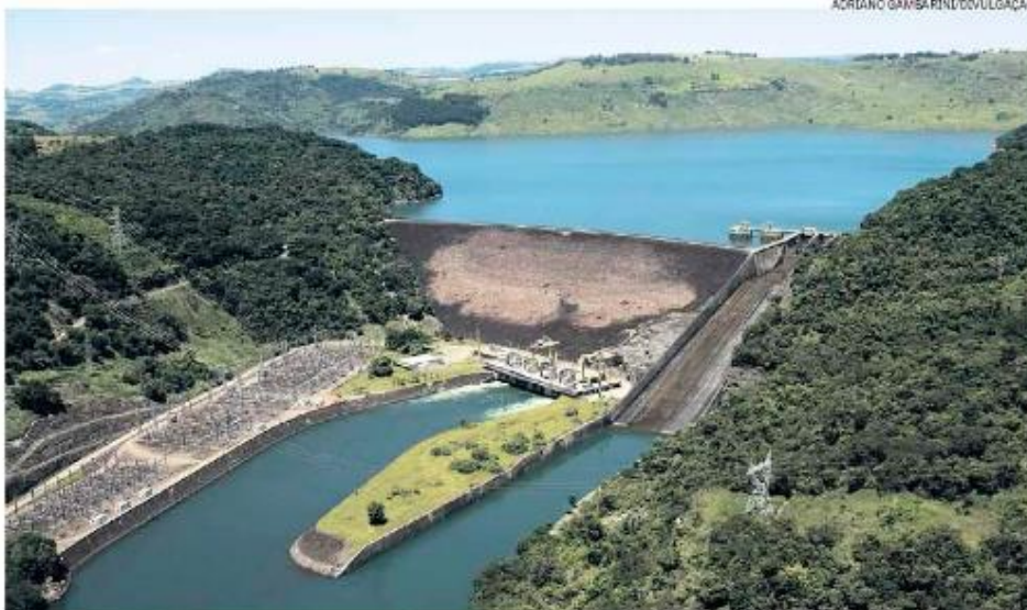
Usina hidrelétrica de Chavantes: um dos ativos da Duke Energy no País, instalada no rio Paranapanema
