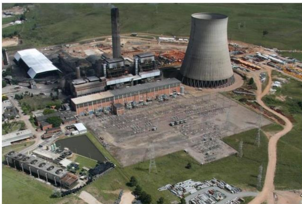
Eletrobras controla a subsidiária CGTEE, que opera usina termelétrica em Candiota, na região sul do Estado Foto: Eletrobras / Divulgação
