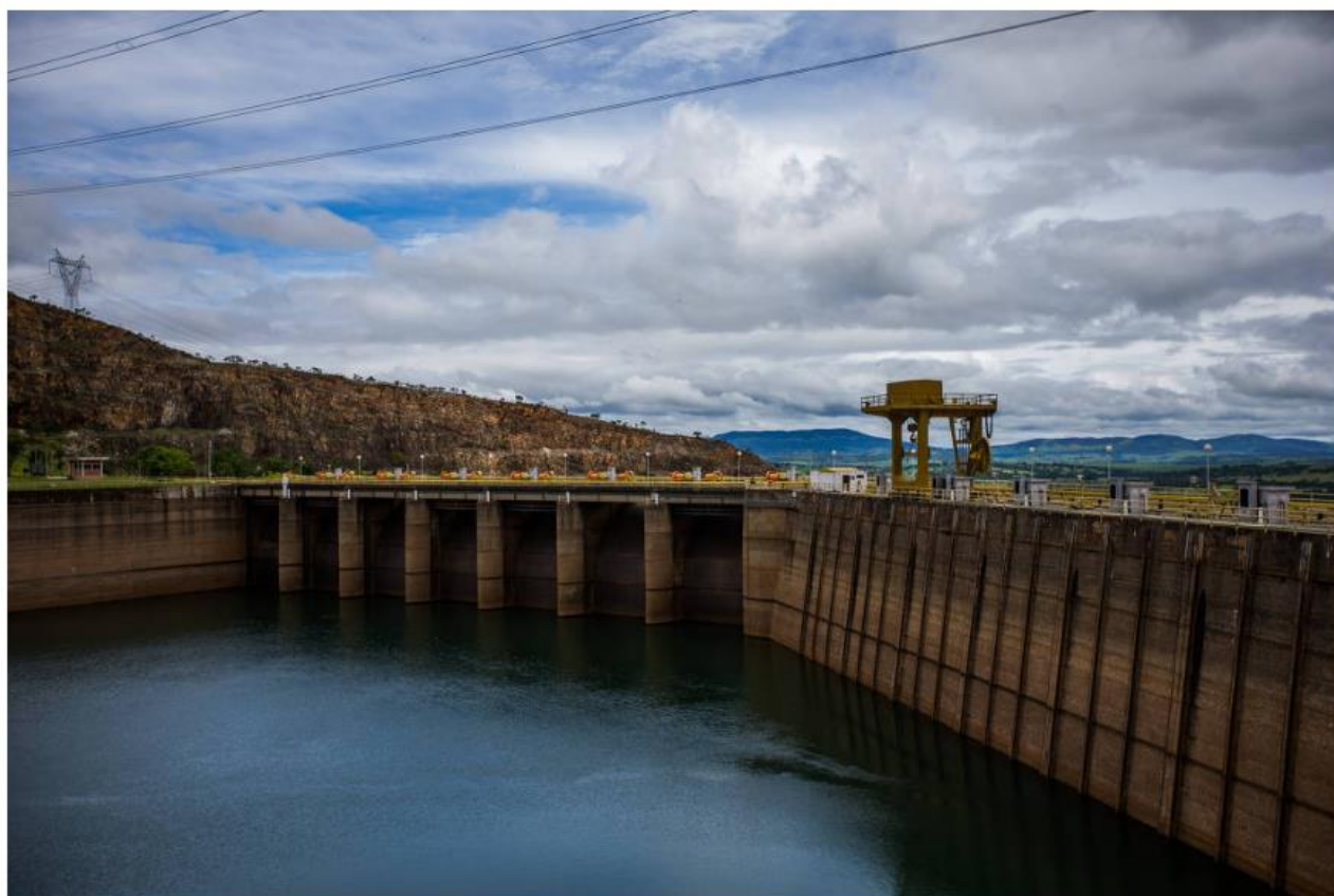
Usina hidrelétrica de Furnas, em Capitólio (MG) - Apu Gomes/Folhapress)
