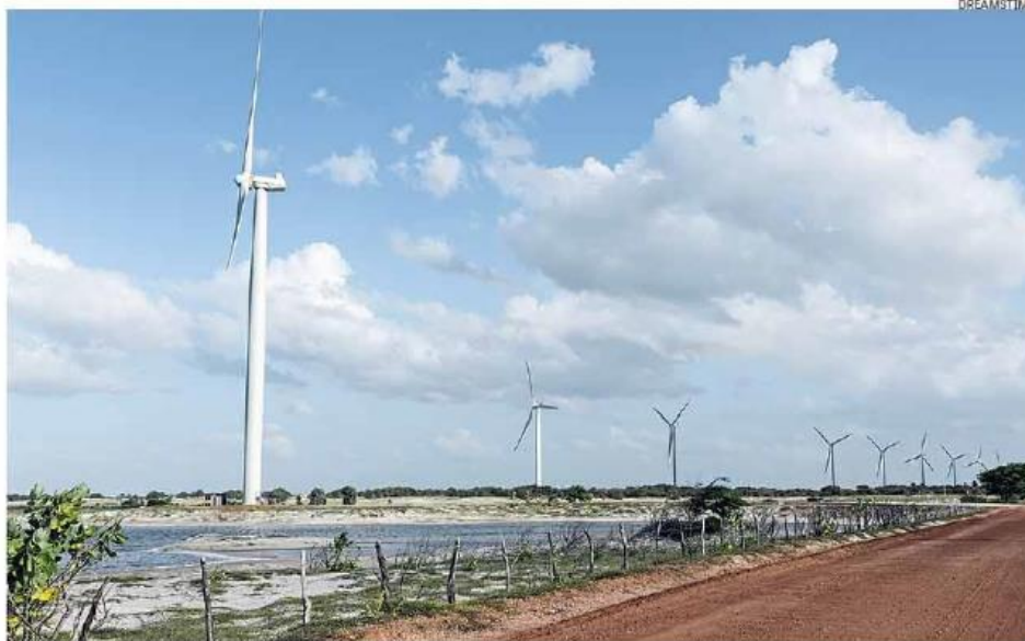
Geradora eólica: renováveis necessitam de mecanismos de proteção para operar no mercado livre
