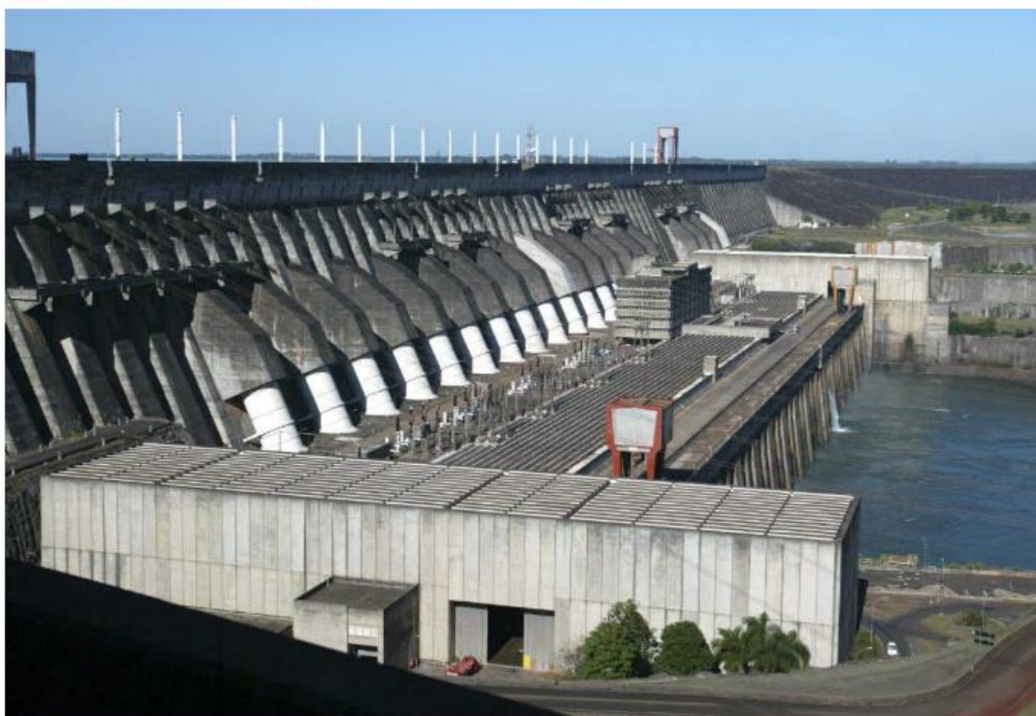
Usina hidrelétrica de Itaipu Binacional, em Foz do Iguaçu (Foto: Rickey Rogers/Reuters)
