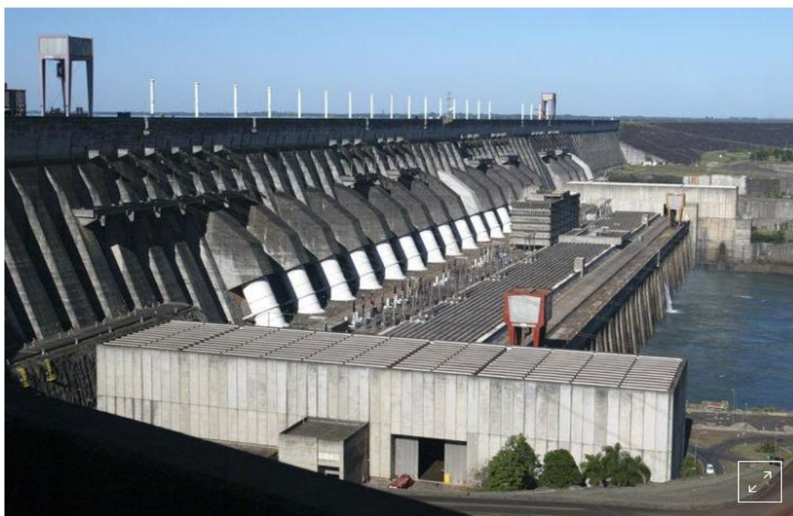
Usina hidrelétrica de Itaipu Binacional, em Foz do Iguaçu (PR) 10/11/2009 REUTERS/Rickey Rogers
