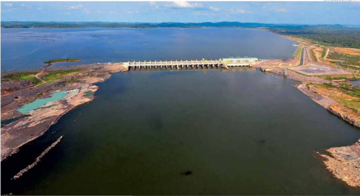
Usina de Belo Monte (PA): custo elevado não remunera o investimento
