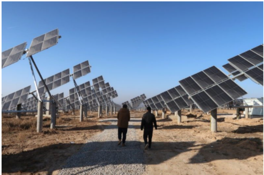
Parque de energia solar na China
