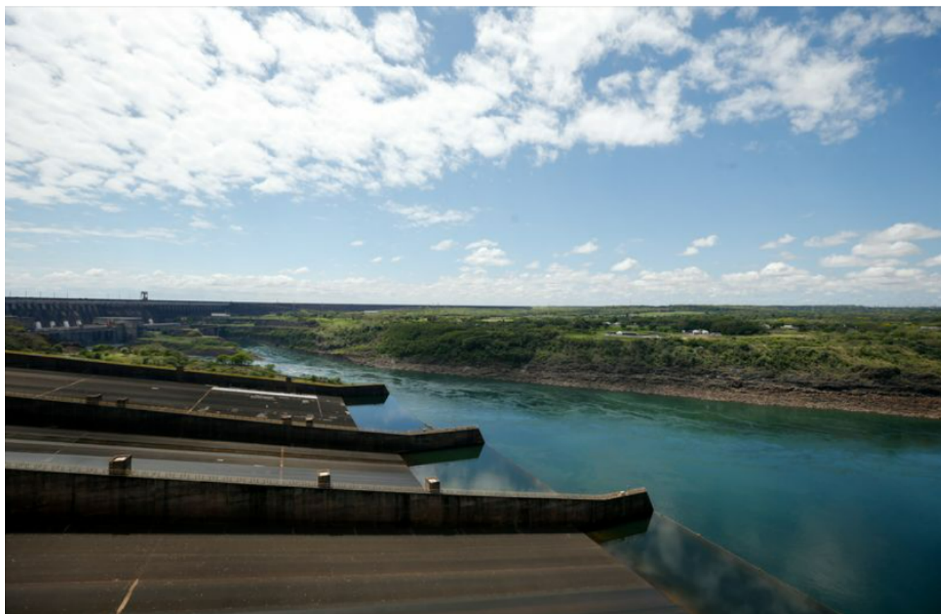
Usina hidrelétrica de Itaipu
