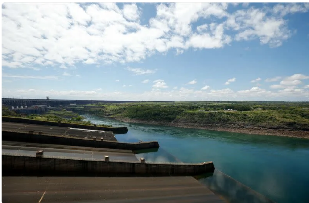
Usina hidrelétrica de Itaipu
