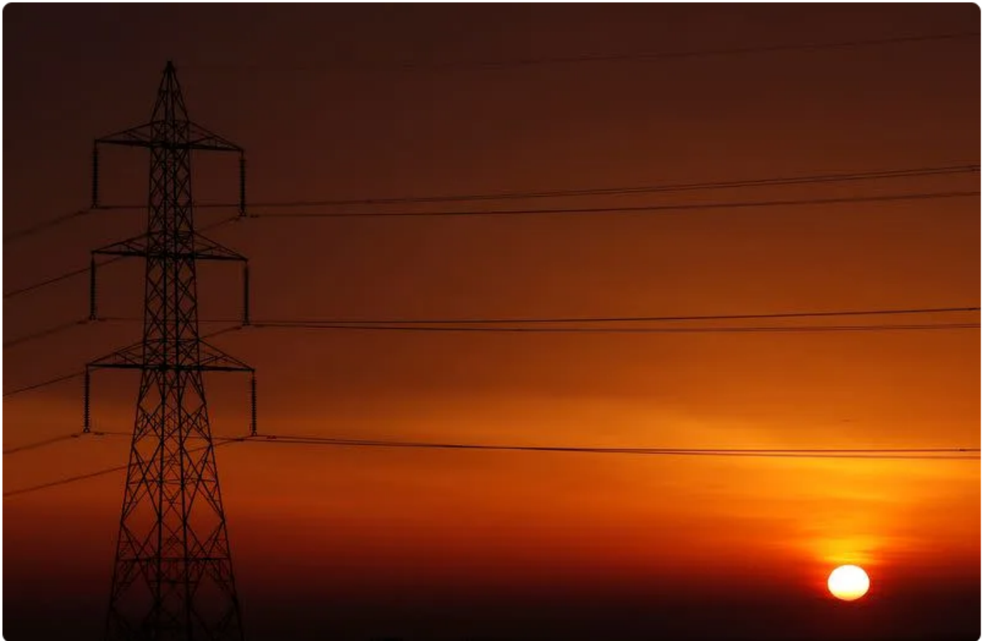
Linha de transmissão de energia
