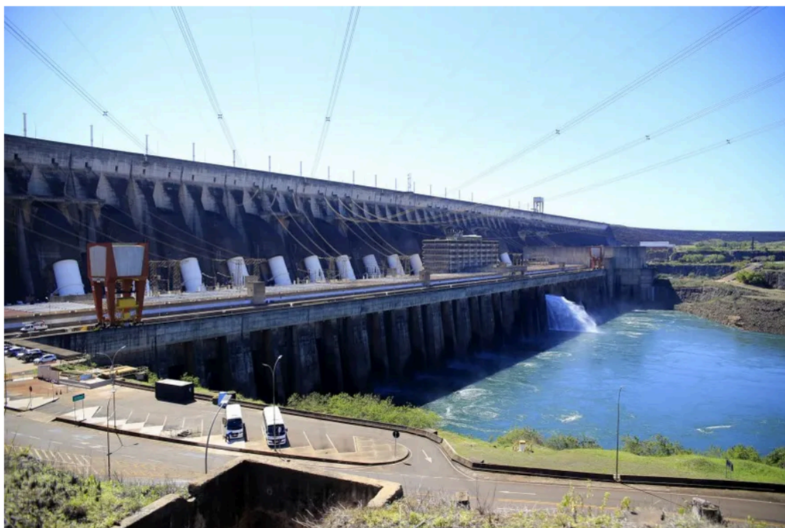
Uma das maiores usinas do mundo, Itaipu tem administração dividida entre Brasil e Paraguai — Foto: Luis Moura/WPP
